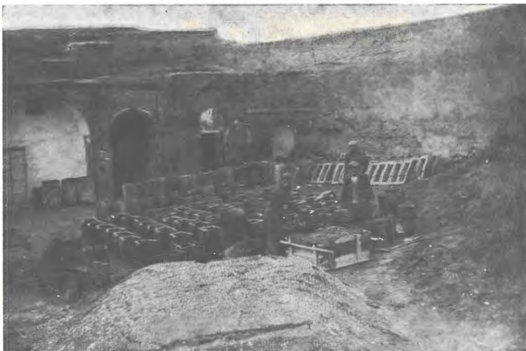
چون لوله سیمانی برای تسطیح کوچه ها و اصلاح جویها و تعبیه مستراحها ساخته میشود
