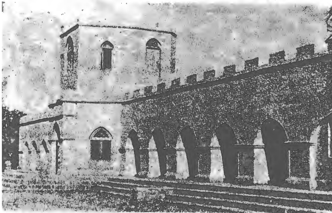
ساختمان درمانگاه زابل
