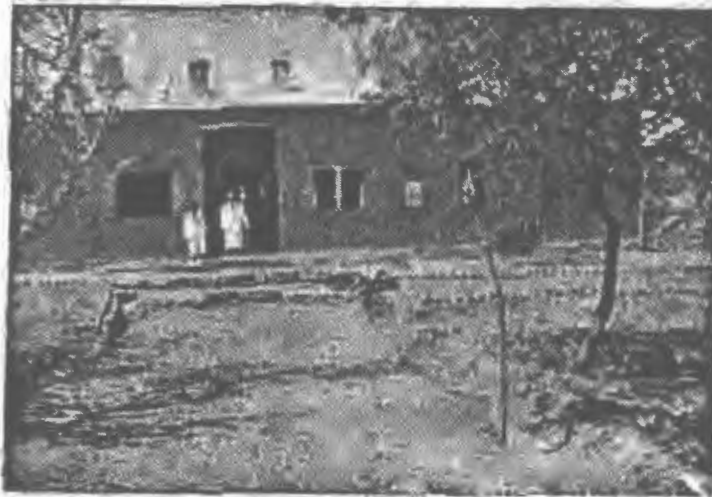
ساختمان درمانگاه پیله سوار
